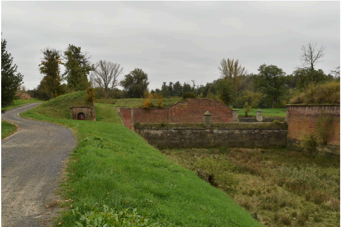
Obr. 2.5 - Pohled na horní stavidla z lávky
