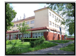
Budova školy - Chabry
