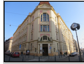
Budova školy - Stross. nám.
