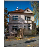
Budova školy - Strašnice
