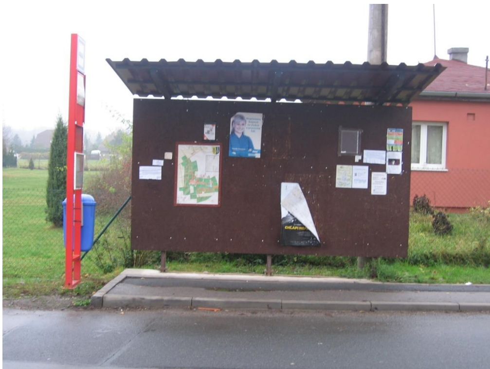
Obr. 31, Přezletice, Vinořská, směr Praha
