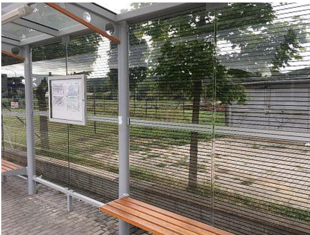
Obr. 41, přístřešek na autobusovém nádraží v Tišnově po zabezpečení. Převzato z cso.cz.
