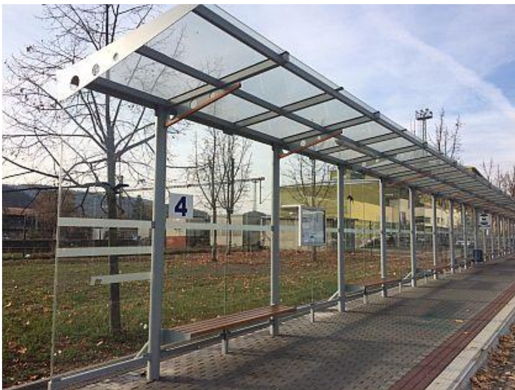
Obr. 40, přístřešek na autobusovém nádraží v Tišnově před zabezpečením. Převzato z cso.cz.
