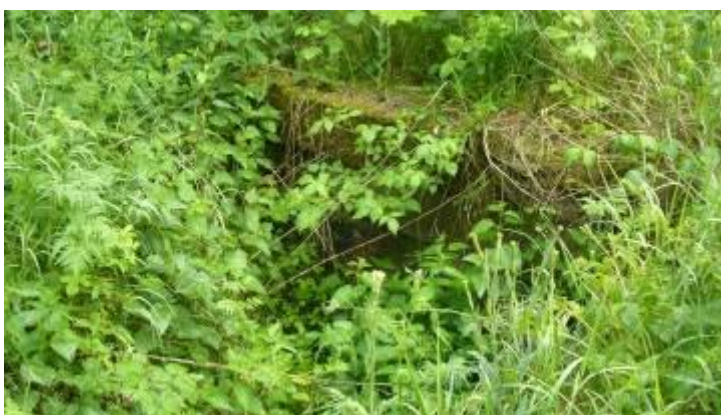
64 - Most přes C11
