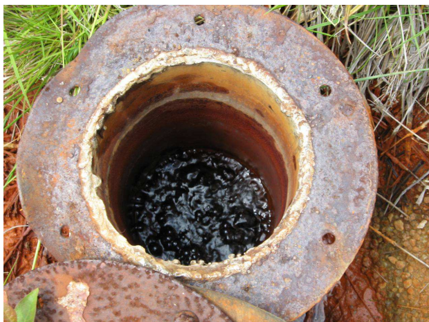
(Příloha 18) Obecní pramen u obce Čihaná pramen je zachycen v kovové trubce, která je zakryta odsunutelným víkem, pramen leží na zelené cyklotrase
