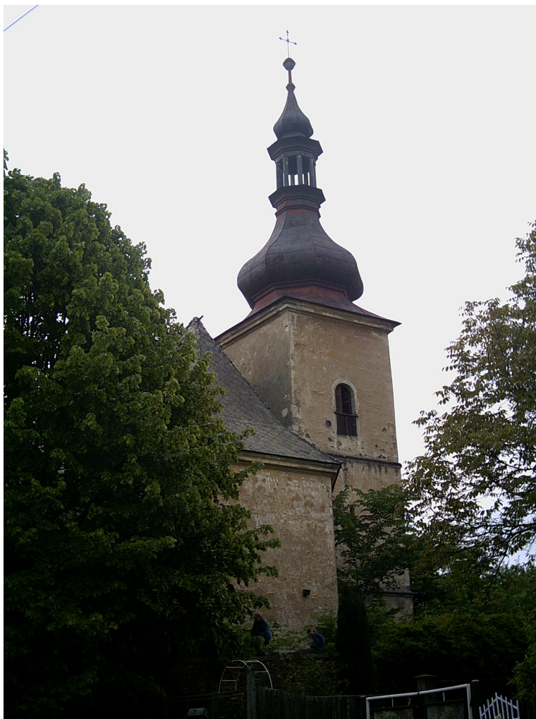
celkový pohled na kostel
