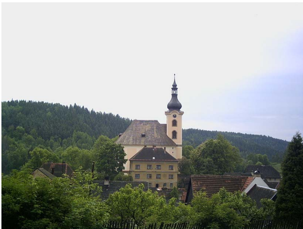
celkový pohled na kostel
