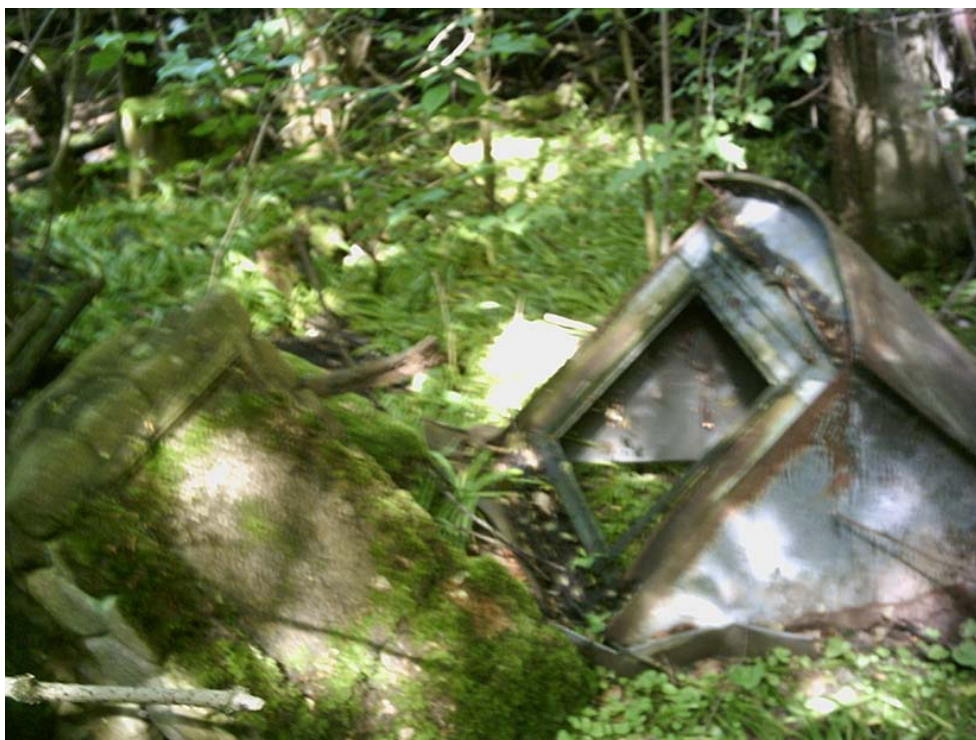
pohled na rozbořený hřbitov a spadlý vikýř v Křivcích
