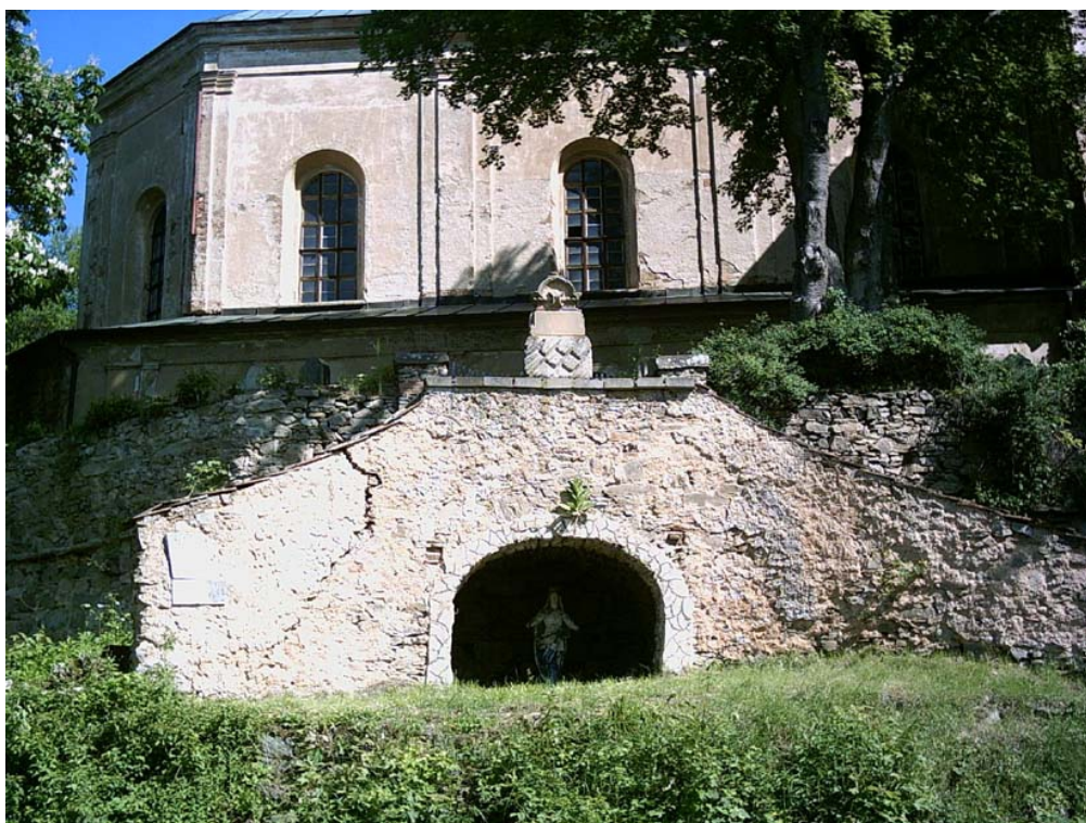
pohled na vstupní schodiště do kostelní zahrady
