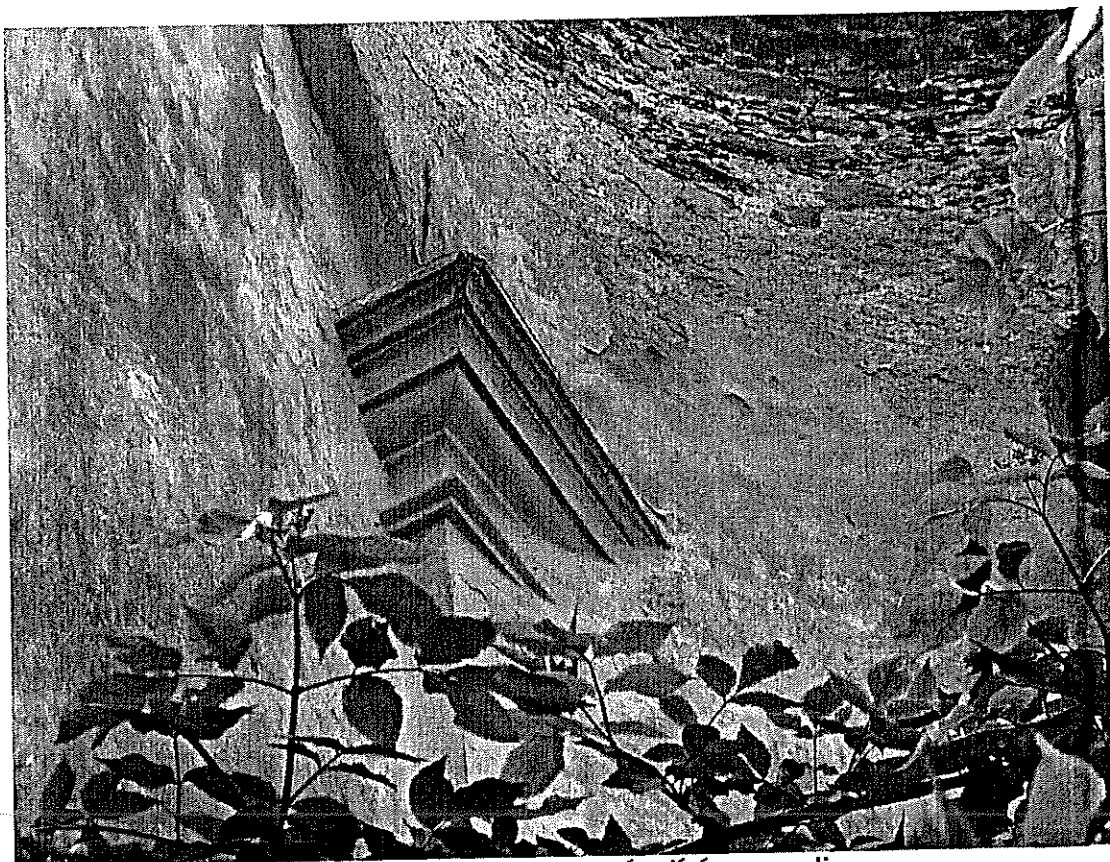
Také zbytek pilastru ztrácející se ve zdi
