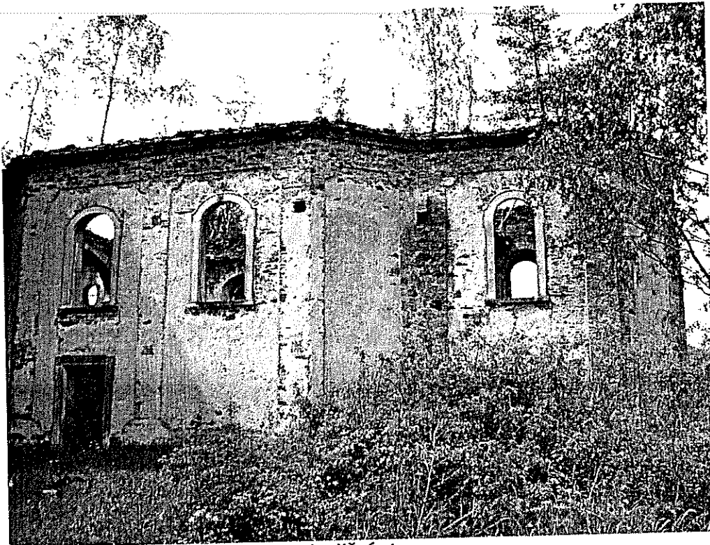
Pohled z jižní strany
