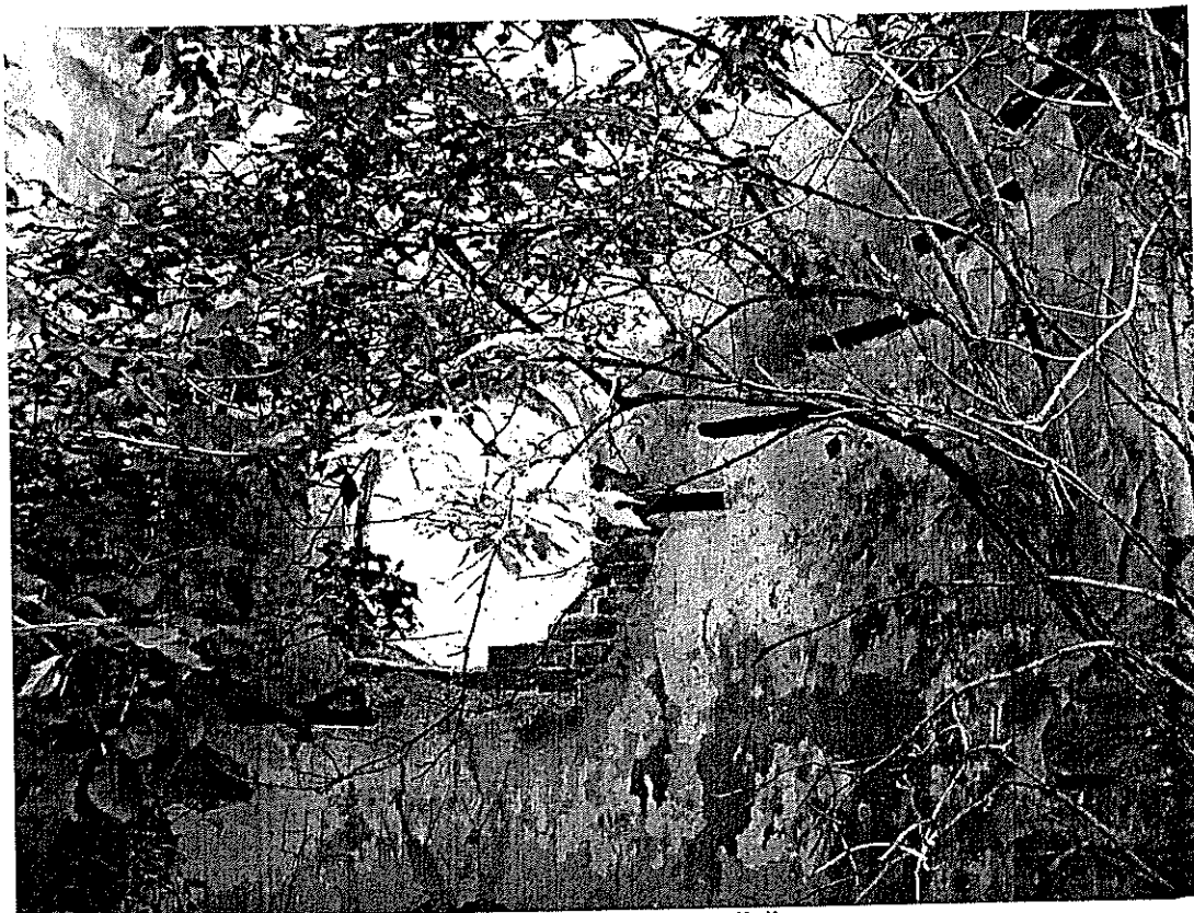
Bývalé točité schodiště
