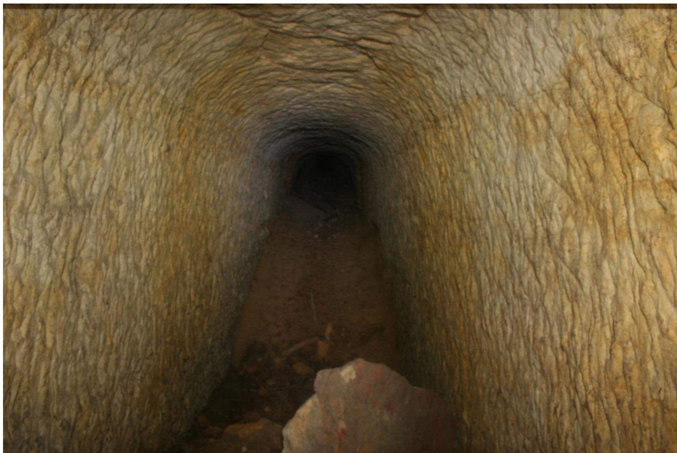
(Obr. 5) Zavalená štola v nejhlubším místě dobývky (zabezpečena mříží)
