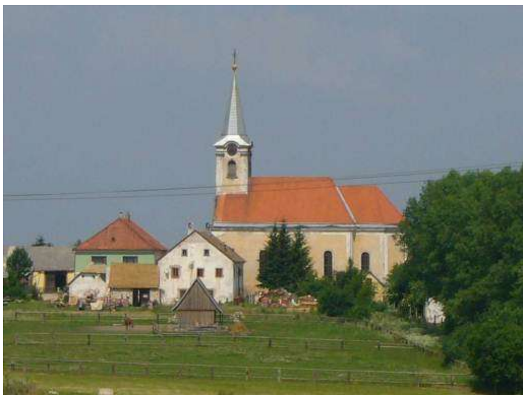
Obr. 13 – Kostel v obci Hůrky (autor: Matouš Bičák, 2007)
